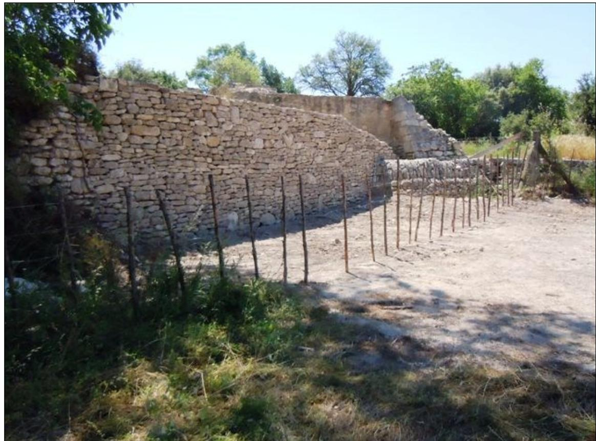
Côté plaine, un mur en pierres sèches de 164 m de long sur plus de 3 m de haut maintient la digue de la retenue d'eau. Celui-ci est effondré en plusieurs endroits. Après avoir, en 2011, déblayé les substructures du moulin côté Sud, TMJ a choisi d'investir (11 000 €) dans le travail d'une entreprise pour remonter le mur immédiatement au Nord des bâtiments .
